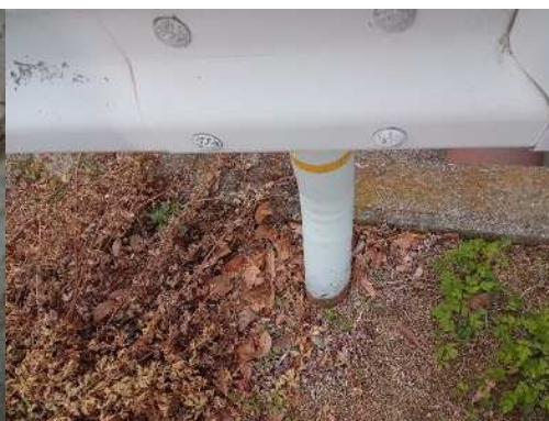
写真 2-4 ガードレール支柱のある植栽帯の草
