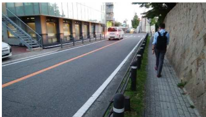
写真 2-3 ガードパイプ支柱周辺の草
