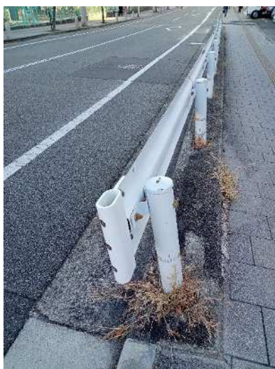
写真 2-1 コンクリート製基礎部窪みの草
