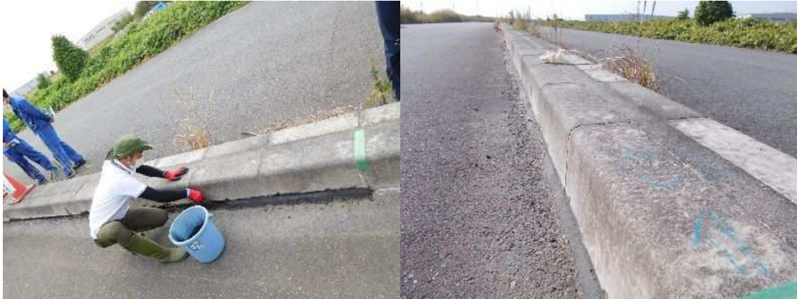
写真 4-7 パッキング施工の様子 (R3. 10. 13)
