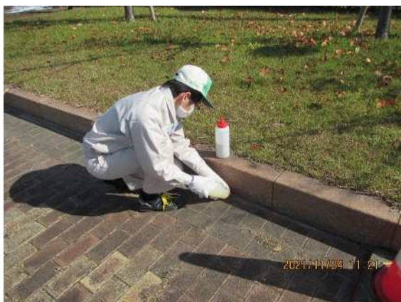
写真 4-3 パッキング施工の様子 (R3. 11. 24)
